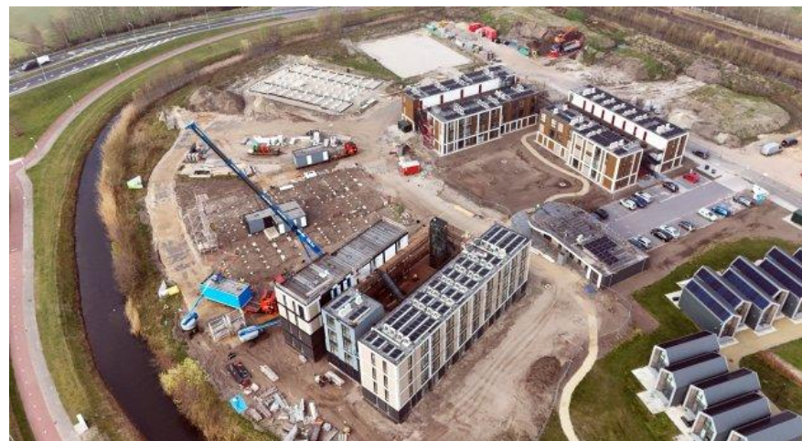
Afbeelding: Bouw van Wonen bij Jaap (252 flexibele sociale huurwoningen).
