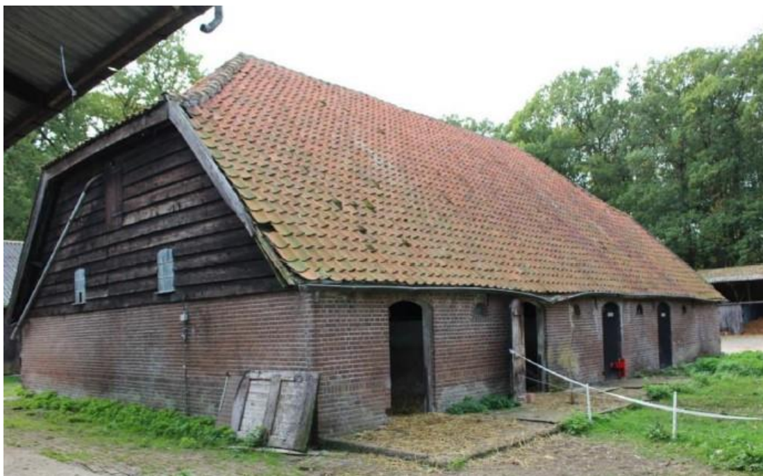
Bestaande situatie gemeentelijk monument veeschuur
