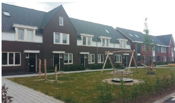
Nieuwbouw met speelvoorzieningen
