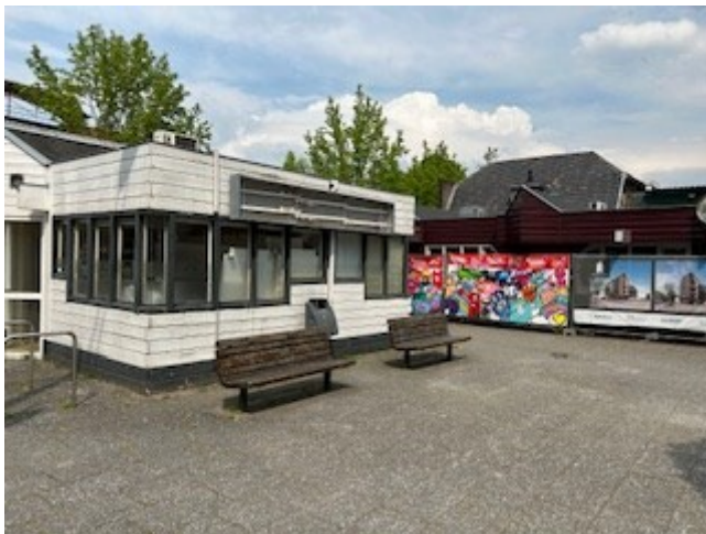
Foto: aangezicht SNS-gebouw en Chinees Restaurant Phoenix.
