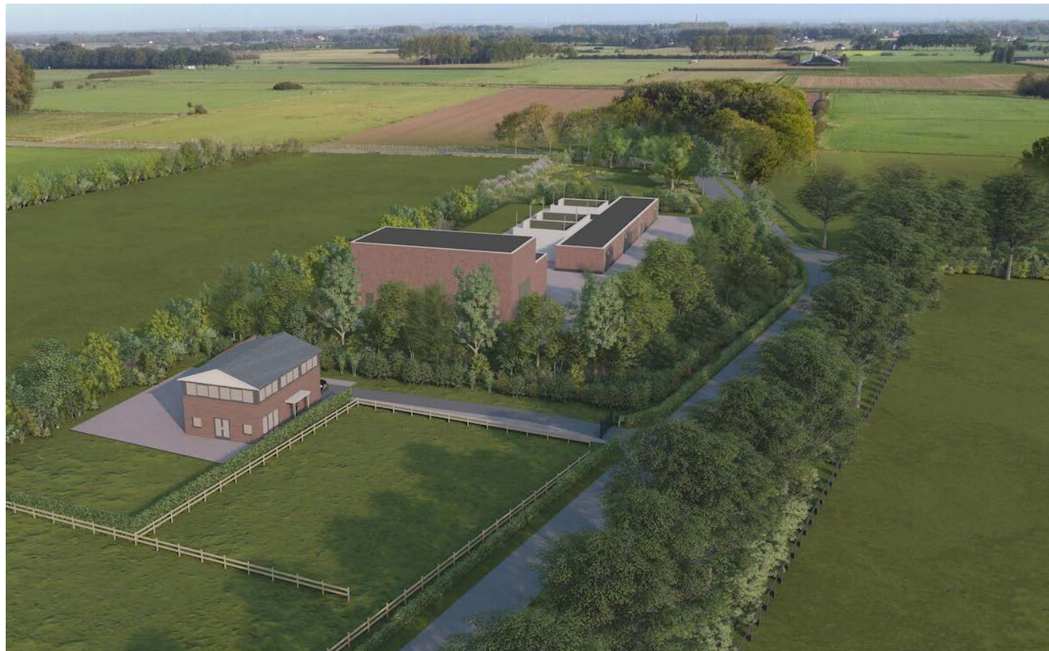
Referentie erfopstelling, station met rode baksteen en betonnen trafocellen Wylerbergmeer in Beek
