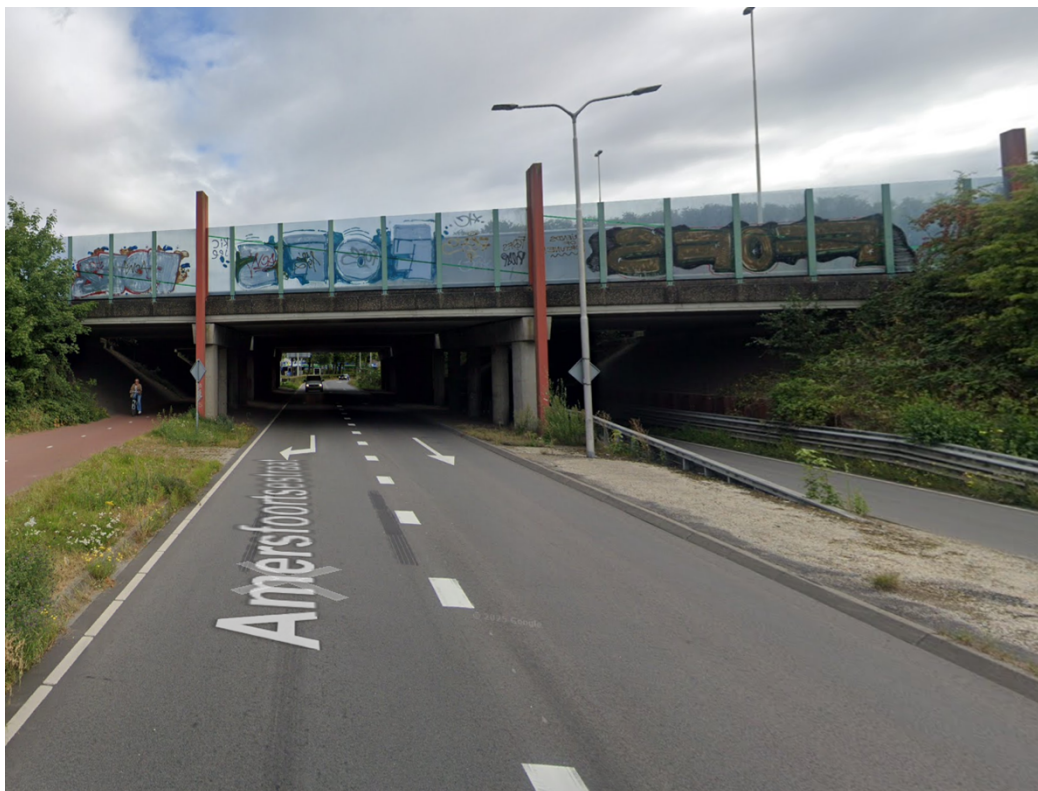
Viaduct A1-Amersfoortseweg (bezien vanuit de Amersfoortsestraat richting Westerdorpsstraat)
